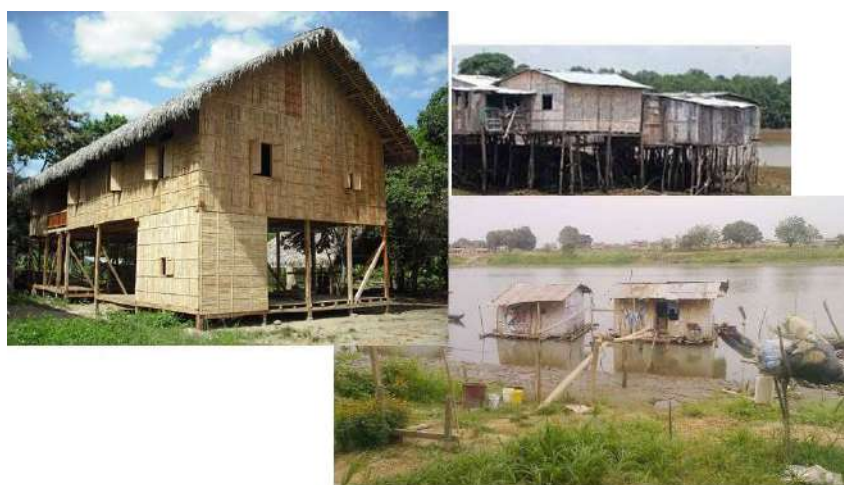
Figura 23: Casas de caña en la costa de Ecuador: casa grande de campo, casas humildes en esteros alrededor de Guayaquil, y casas sobre balsas en Babahoyo.
