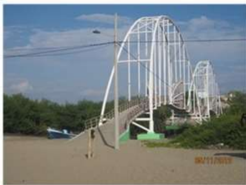
Vista del puente peatonal de Bellavista. La carretera sale del otro lado a Campoalegre.
